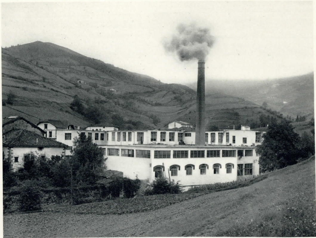
Vista exterior, lado Norte.
