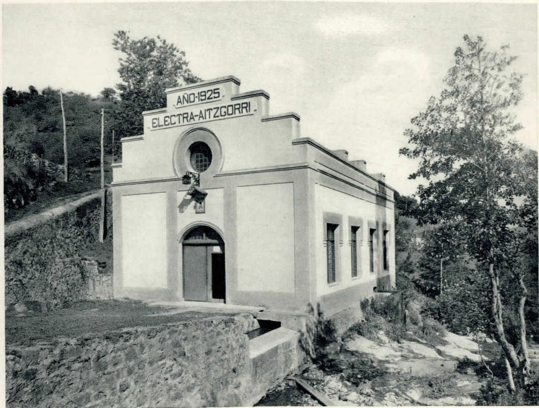
Central Hidroeléctrica. Desnivel, 330 metros.
