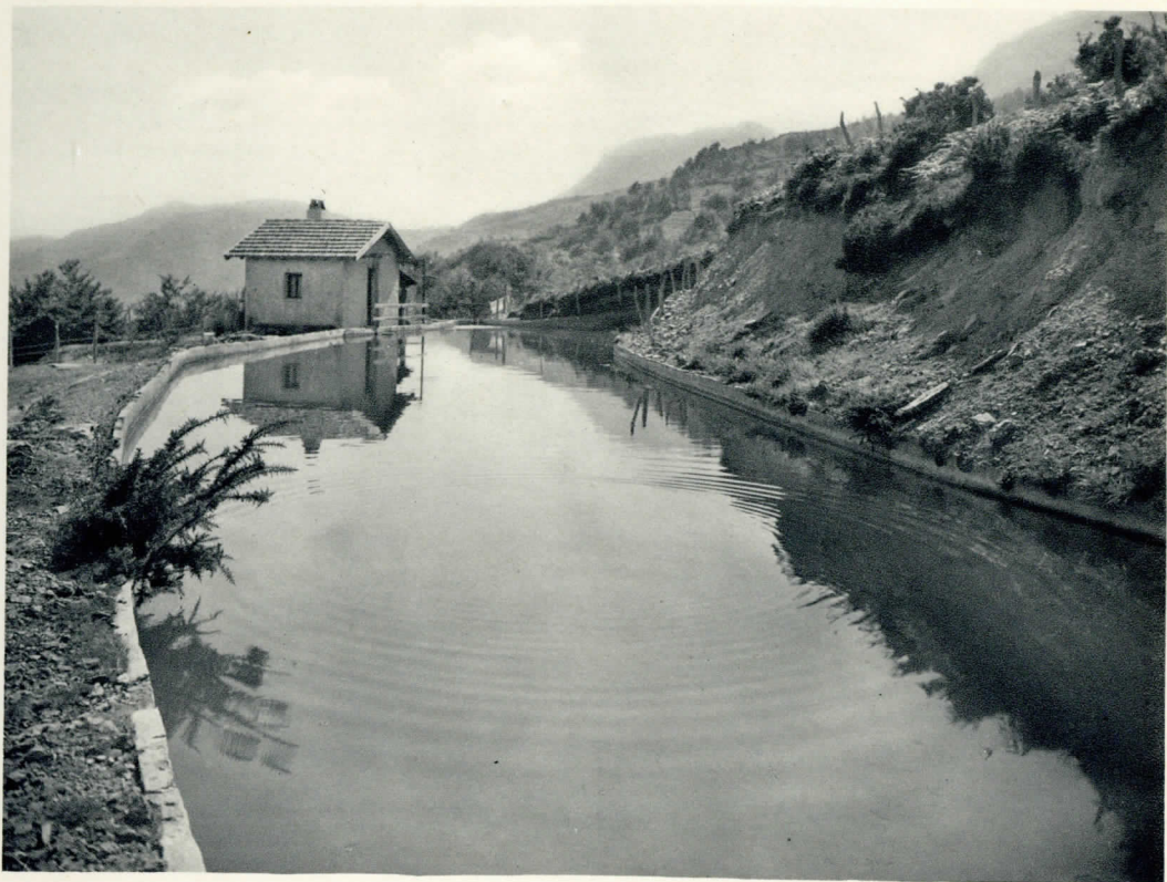
Depósito regulador a 330 metros de altura.
