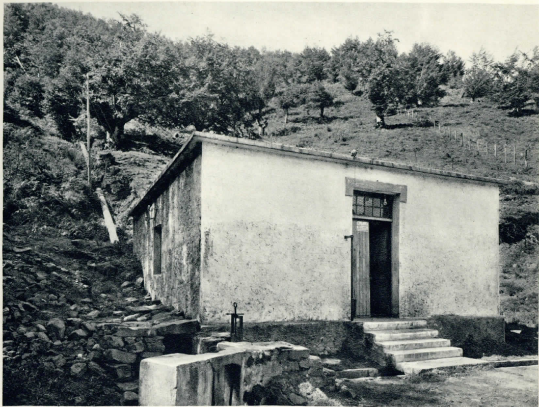
Central Hidroeléctrica "San Adrián". Desnivel, 130 metros.
