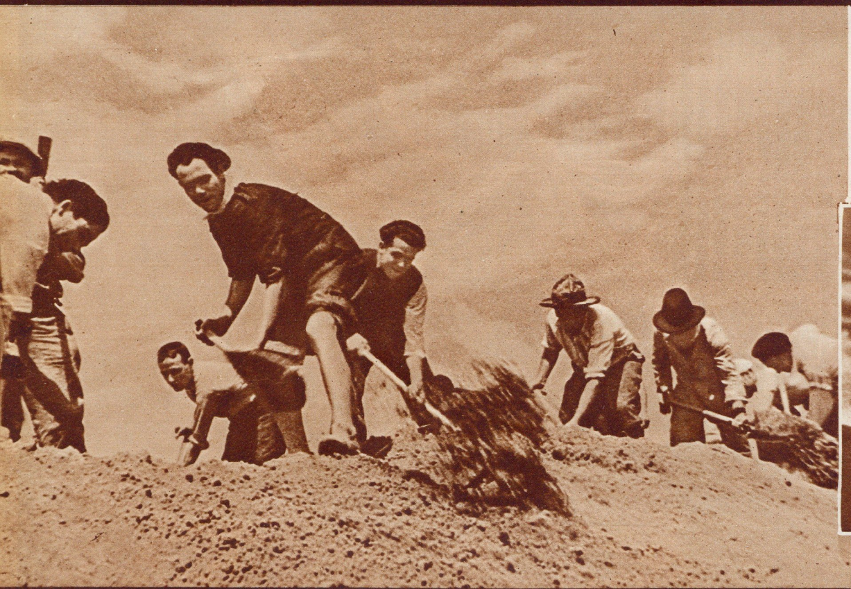
Uprostřed války vznikla nová, druhá trať z Madridu do Valencie. V úžasně rychlém tempu — jenom čtyřicet dní bylo předpokládáno pro stavbu — byly skončeny pozemní práce armádou dobrovolných pracovníků.
