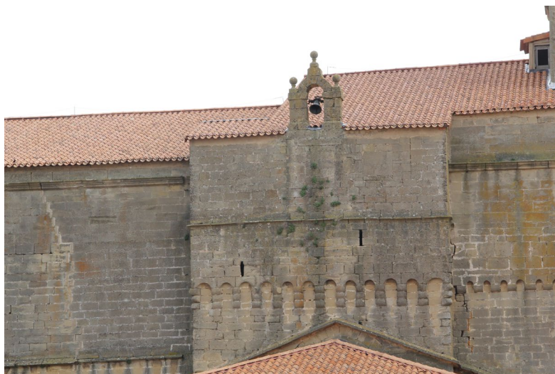
Nº 4. Detalle de los restos de la torre-fortaleza medieval de Elvillar-Álava, adosados al muro norte de la parroquia de Nuestra Señora de la Asunción.
