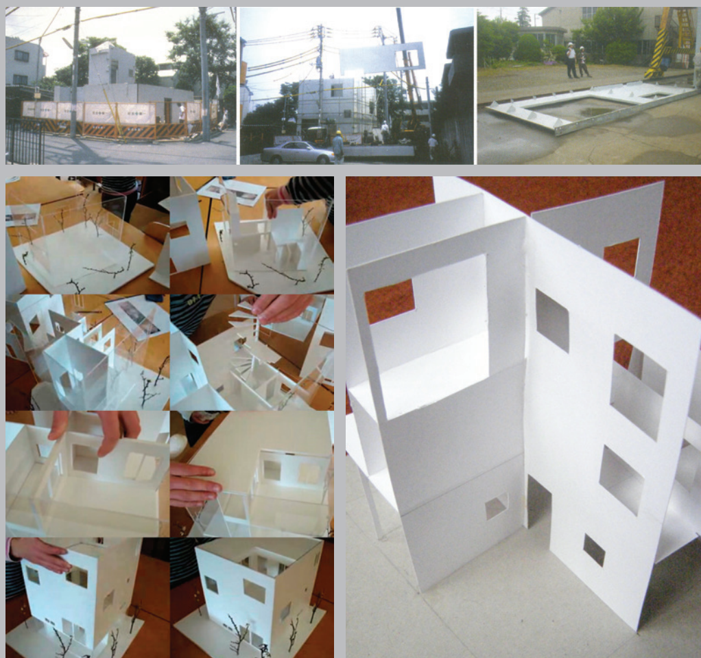
Fig.37. (Arriba) Proceso de construcción de la estructura de la casa. / Fig.38. (Abajo izquierda) Proceso de construcción de la maqueta de la casa. / Fig.39. (Abajo derecha) Maqueta construida por el autor en la que se aprecian alabeos de los planos verticales.
